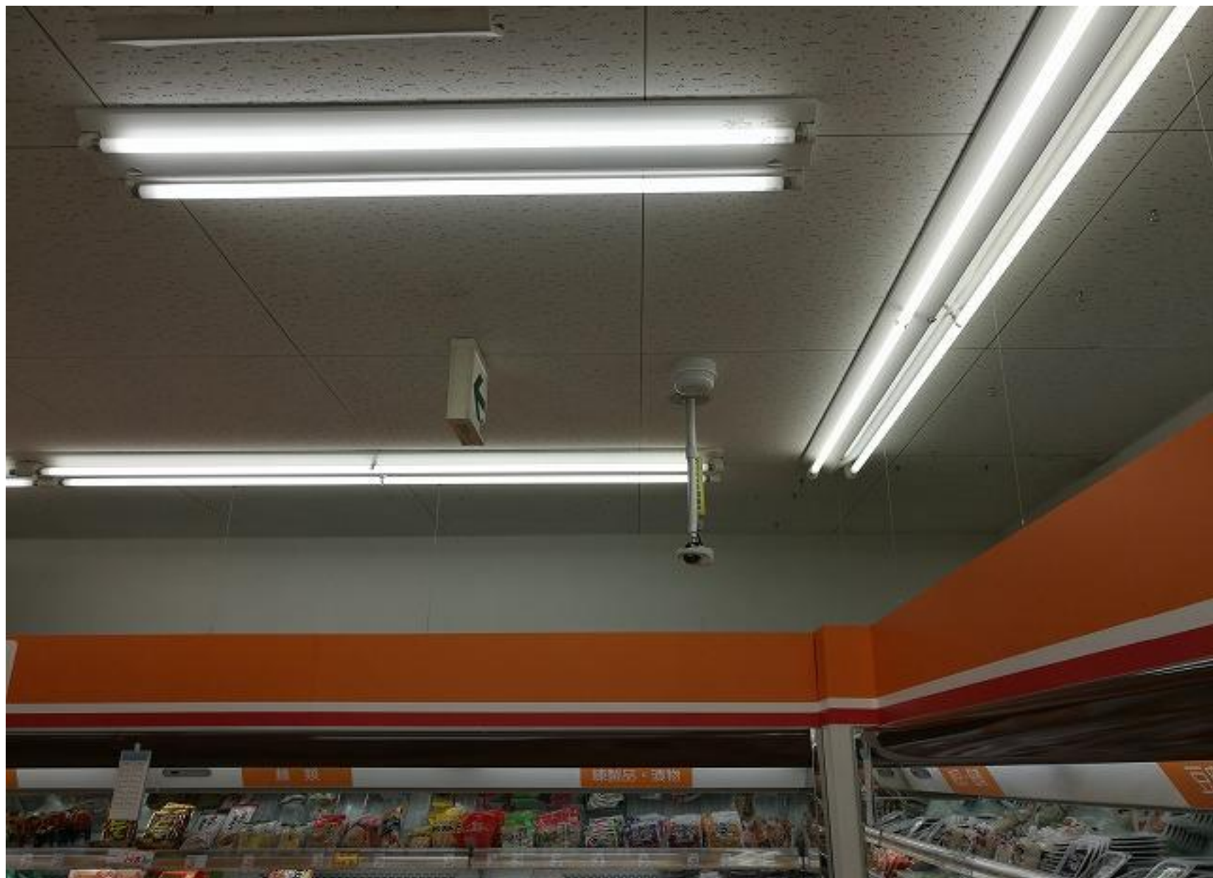
【是正对象施工後】
