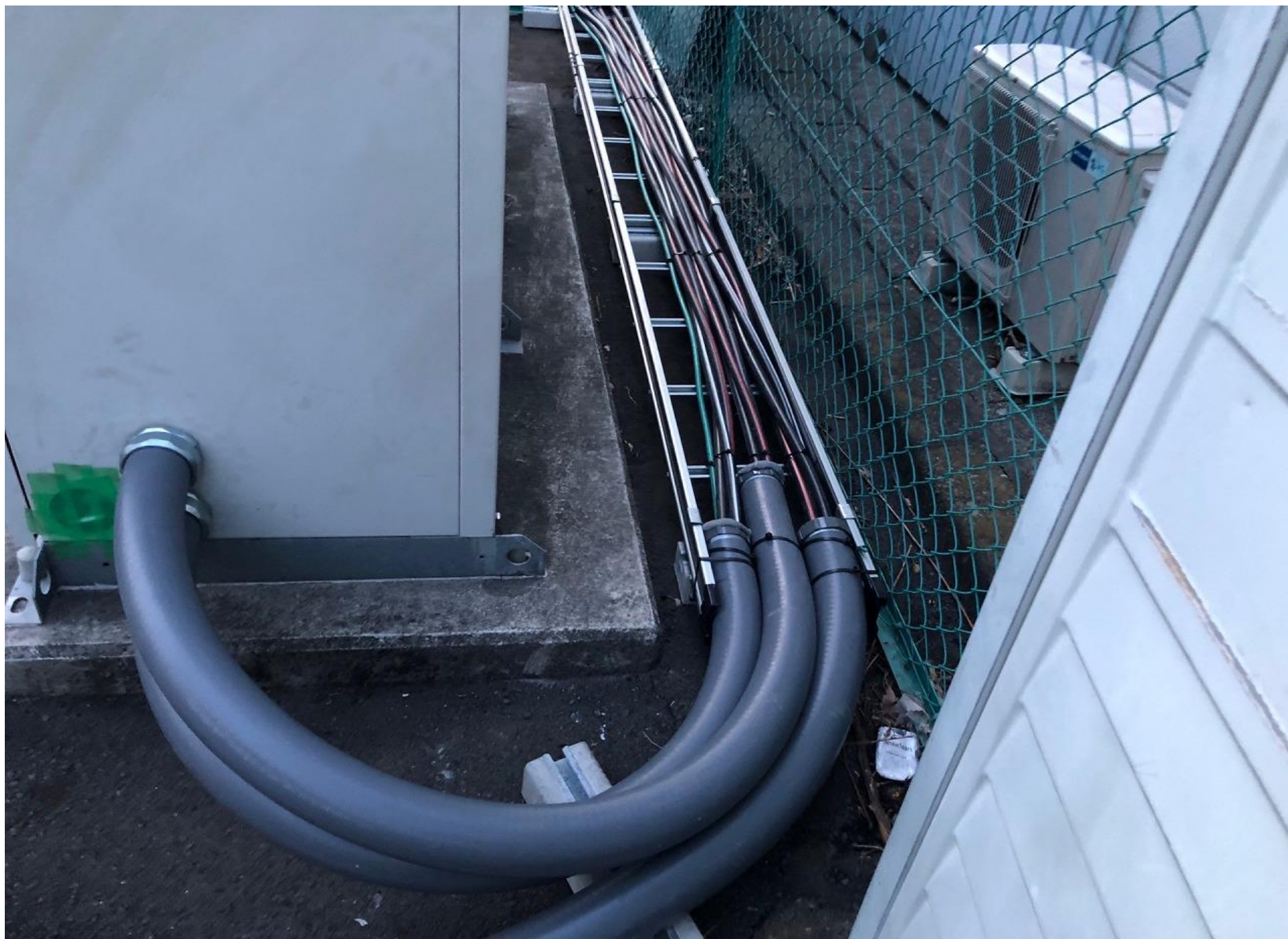
【施工途中様子】
